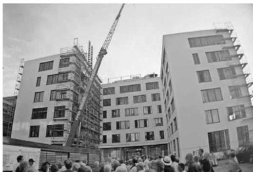
Mit dem sechsstöckigen Neubau an der Frankenstraße, den 2019 die Firma SDV-IT bezieht, bringt die KIB-Gruppe die Bebauung des FrankenCampus zum Abschluss. F.: Volkan Altunordu
