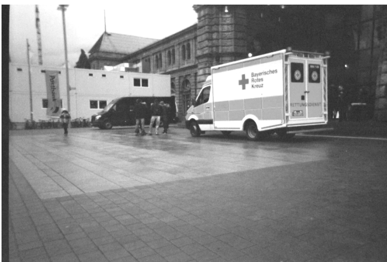
Bahnhofsvorplatz während der Umbauarbeiten. Die Königstörpassage liegt „einen Stock tiefer“.
